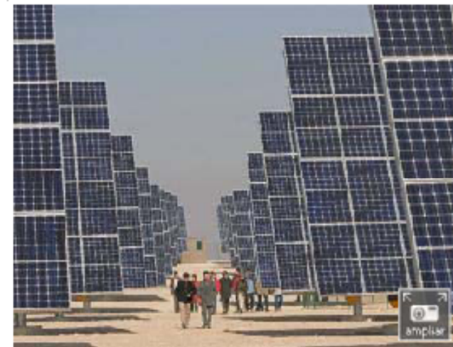
Panorámica de la planta solar fotovoltaica situada en la localidad navarra de Cintruénigo.-
